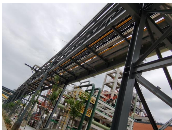
架空物料管线
